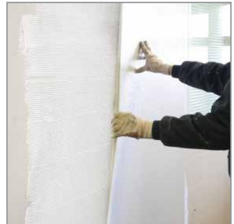
2. ... Glasbord Paneele im richtigen Maß passgenau anbringen...
