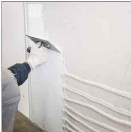
1. So einfach ist die Direktmontage von Glasbord auf vorhandene Untergründe. Kleber auftragen...
