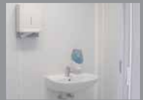
Sanitärbereiche Leicht zu reinigen
