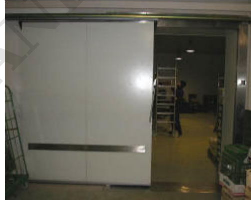
Kühlraumschiebetür in RAL9002 mit zusätzlicher Anfahrerschutzleiste
