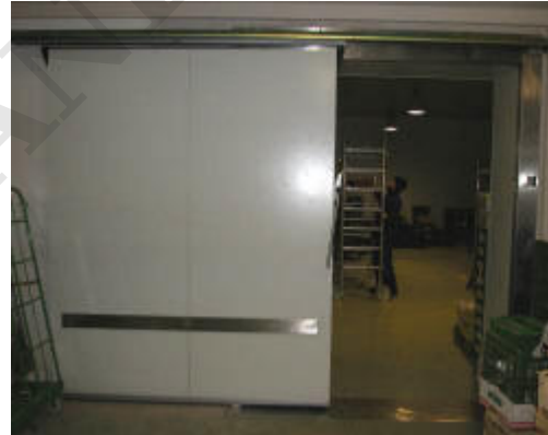
Kühlraumschiebetür in RAL9002 mit zusätzlicher Anfahrtschutzleiste
