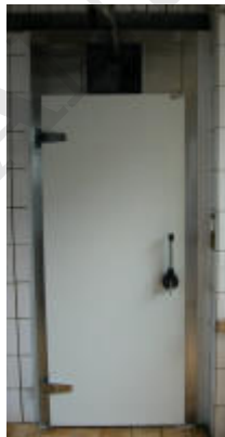
einflügelige KR-Drehtür RAL9002 Falztürblatt mit Rohrbahnaufsatz
