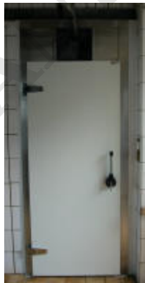
einflügelige KR-Drehtür RAL9002 Falztürblatt mit Rohrbahnaufsatz
