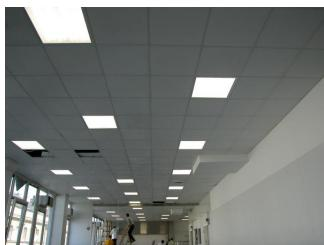
mit GFK, Metal oder Mineralfaserplatten, über der diverse Installationsleitungen o.ä. laufen, die jederzeit zugänglich sein müssen.
