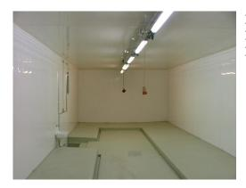
Die Paneele eignen sich für kostengünstige, fugenlose Decken- u. vor allem Wandverkeidungen, in Feucht-, bzw. Nassräumen. (Hochdruckreinigung möglich).
